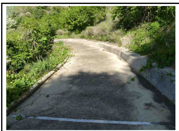
사진번호 71 시점 소단 배수로 전경 외관망도 -
