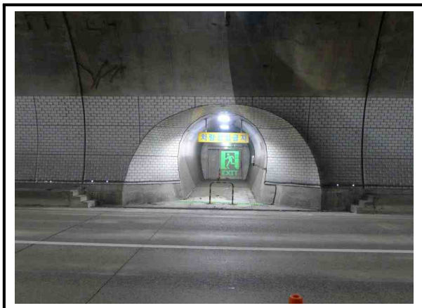
사진번호 67 피난연락갱 S91(인도용) 외관망도 - 상태양호
