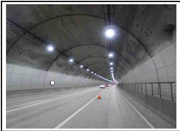
사진번호 7 터널 내부 전경 외관망도 -
