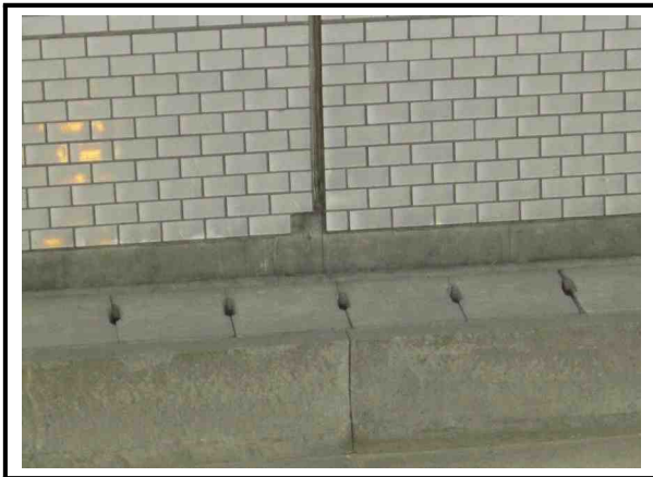
사진번호 31 측벽부 S44 좌측 타일탈락, 파손 외관망도 20-1
