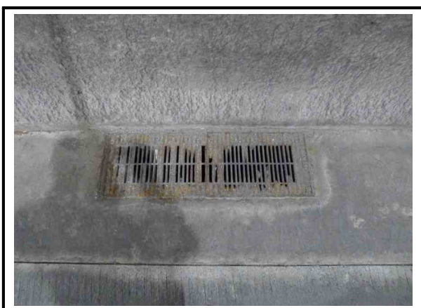
사진번호 11 배수시설 전경 외관망도 -
