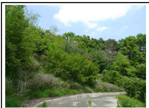
사진번호 69 시점부 사면 식생 활착 및 외관망도 - 수목 발달
